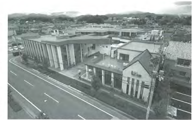
写真1 地域に開いた施設全景
